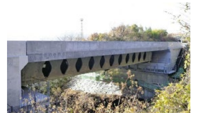
錆びない橋として注目されている徳島県の「別荘谷(べっそだに)橋」;西日本高速道路(株)
